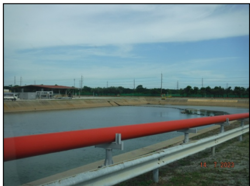
บ่อรวบรวมน้ำฝนที่มีโอกาสปนเปื้อน (Potentially Contaminated Storm Water Holding Pond)
