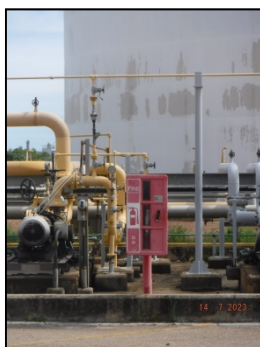
รูปที่ 3-46 ตัวอย่างอุปกรณ์ป้องกันและระงับอัคคีภัย
