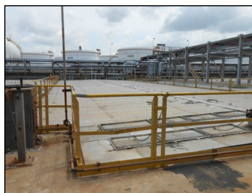
รูปที่ 3-18 ฝापิดที่ API Oil/Water Separator
