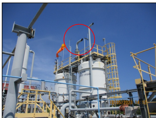
รูปที่ 3-20 Outlet ของ VRU
