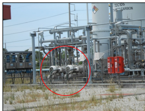
รูปที่ 3-21 Pump/Blower ของ VRU
