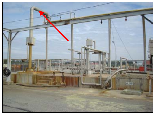
รูปที่ 3-10 ระบบตรวจอากาศจากบ่อซัลเฟอร์
