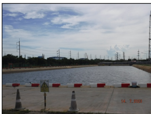
บ่อพักน้ำเสียที่ผ่านการบำบัดแล้ว (Polishing Pond)
