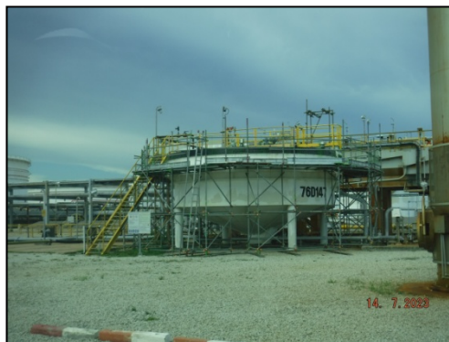
หน่วยแยกน้ำมันออกจากน้ำเสีย (API Separator Unit)
