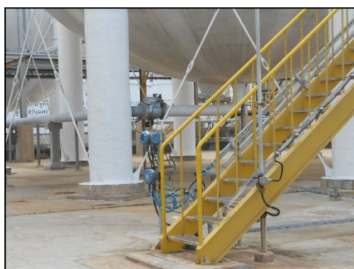
รูปที่ 3-42 Gas Detector
