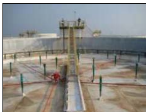
รูปที่ 3-50 ระบบกันระเหย 2 ชั้น (Double Seal) ที่ Floating Roof Tank
