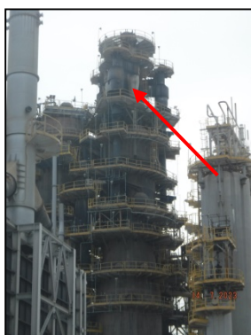
รูปที่ 3-11 Cyclone ที่ RFCCU
