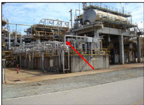
รูปที่ 3-10 ระบบตรวจอากาศจากบ่อซัลเฟอร์
