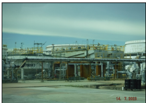
หน่วยแยกน้ำมันออกจากน้ำเสีย (Induced Air Floatation Unit)
