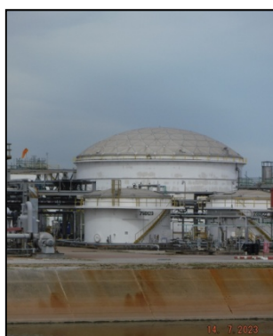
รูปที่ 3-17 ฝารอบถัง Equalization เพื่อลดกลิ่น
